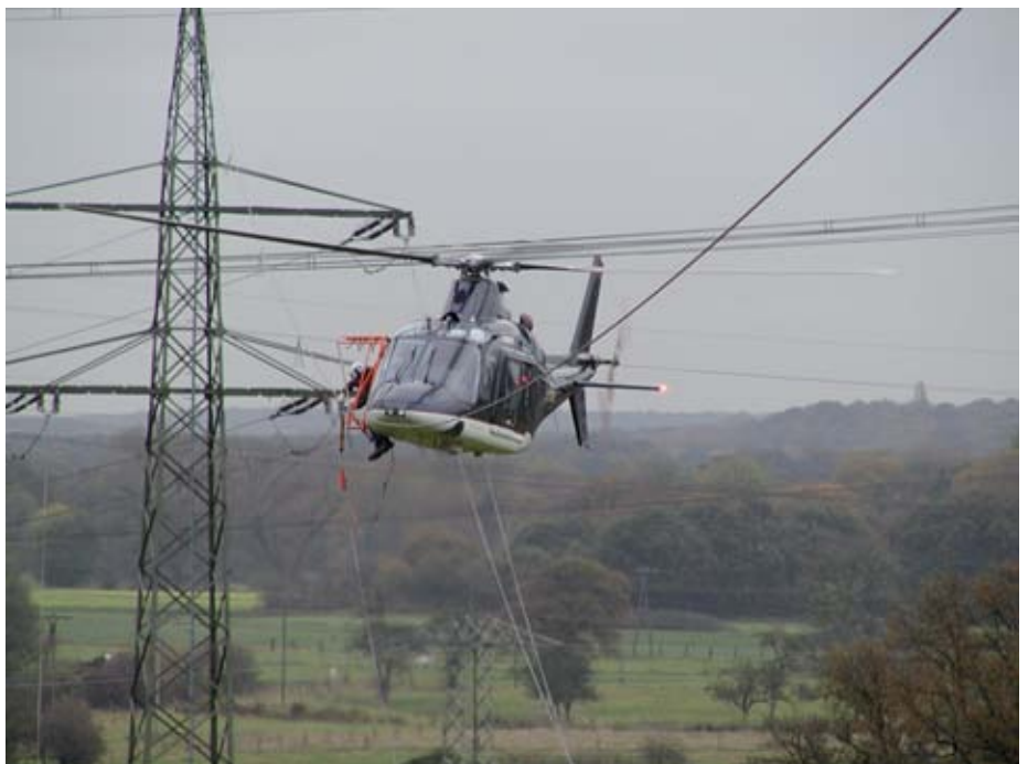
Foto 3: Anflug des Helikopters an das Blitzseil und Herstellung des notwendigen Potentialausgleichs
