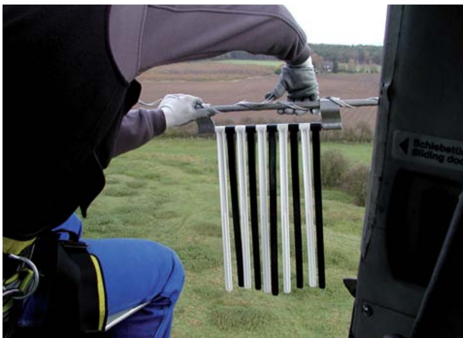
Foto 1: Markierung aus beweglichen schwarz-weißen Kunststoffstäben auf einer Aluminium-Trägerkonstruktion
